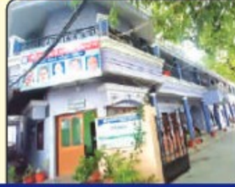
A.C. Room, V.I.P. Room, લિફ્ટની સુવિધા
